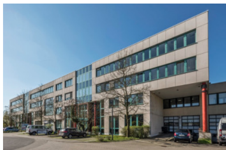
© Foto Falkenberg Park, Quelle: RECON CAPITA GmbH & Co. KG
