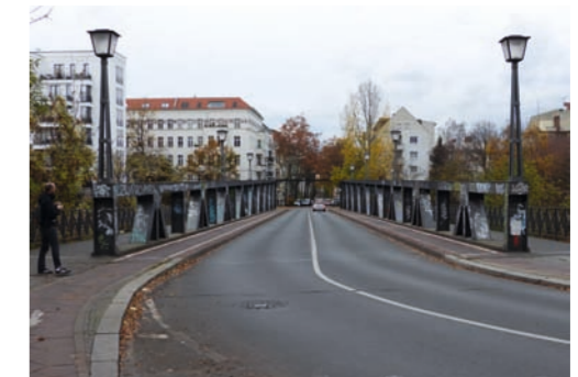
Blick über die Langenscheidtbrücke Richtung Westen
