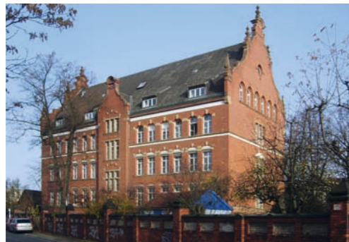
Ehemaliges Kasernengebäude an der General-Pape-Straße
