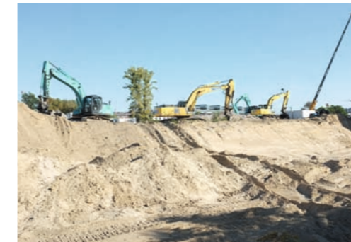
Bauarbeiten auf dem Baufeld 4, im Hintergrund der Bahnhof Südkreuz
