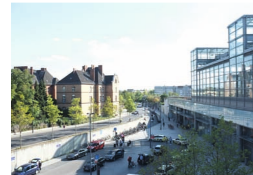
Bahnhof Südkreuz mit Vorplatz Ost
