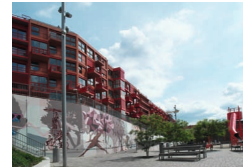
Privater Wohnungsbau „Am Lokdepot“
