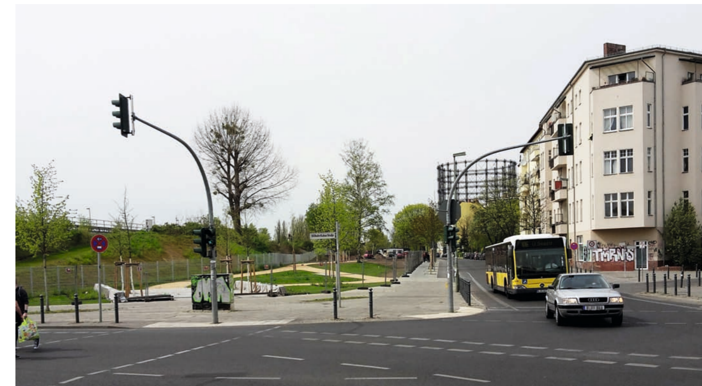
Einmündung Torgauer Straße in die Wilhelm-Kabus-Straße
