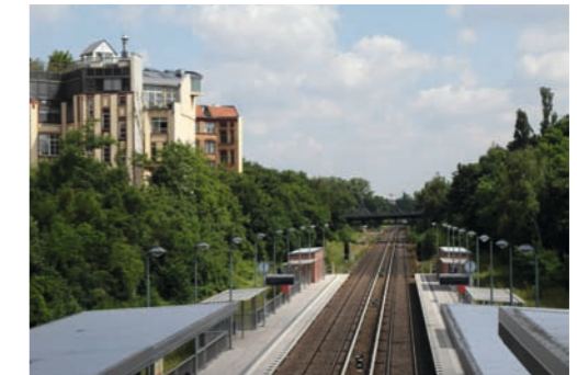
Blick in den Wannseebahngraben von der Leberbrücke zur Langenscheidtbrücke
