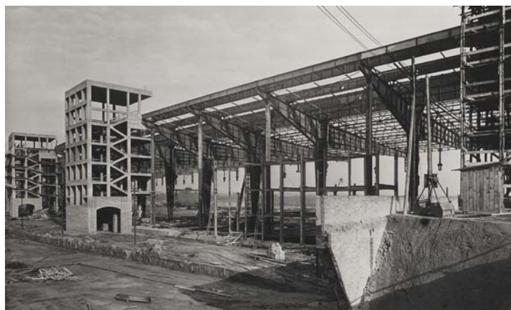
DIE STAHLKONSTRUKTION DER HANGARDÄCHER UND DIE TREPPENHAUSTÜRME IM ROHBAU IM JAHR 1938
