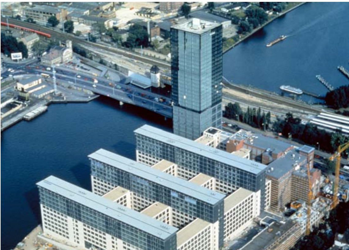
Treptowers, Blick zur Eisenbrücke
