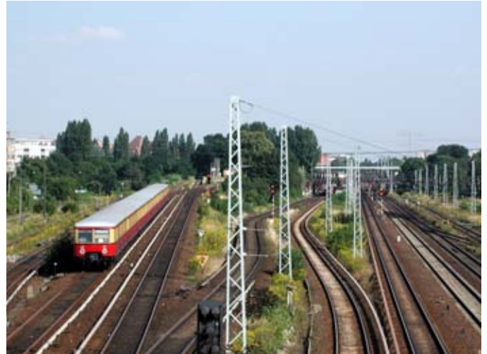
Gleisanlagen östlich der Modersohnbrücke
